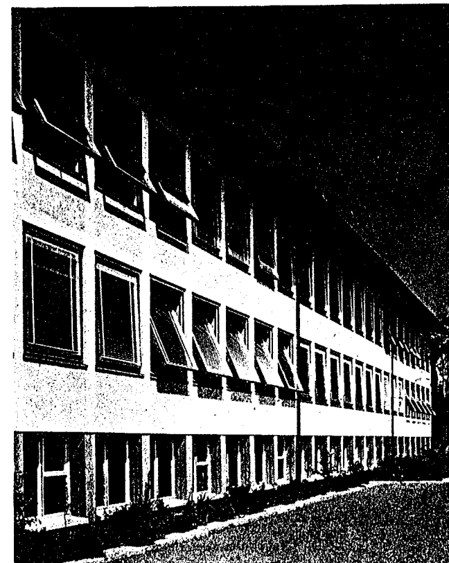
Einflügelige Carda-Fenster. Schulhaus Wetzikon (Schweiz). Hersteller Ernst Göhner AG., Zürich. Architekt P. Hirzel, Wetzikon
