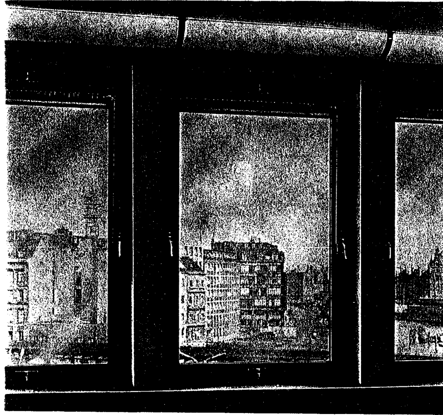
ermanent-Schieberlüftung. Die Lüftungsvorrichtung ist am Flügel angebracht
